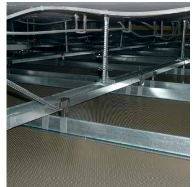
Rückseitig angenieteter L-Winkel zur Befestigung im Klemmprofil. Gewebe: CMP-Alu 6010 (9)
