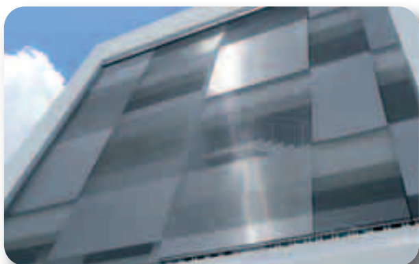
Park Square Doral, Miami/USA Architekt: Zyscovich Architects Gewebe: Omega in unterschiedlichen Dichten (19)
