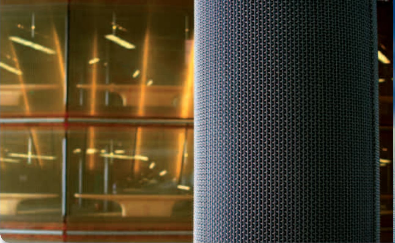
National Grand Theatre, Beijing/China Architekt: Paul Andreu Gewebe: Baltic, vor Ort dunkelgrau lackiert (Säulen) (33)
