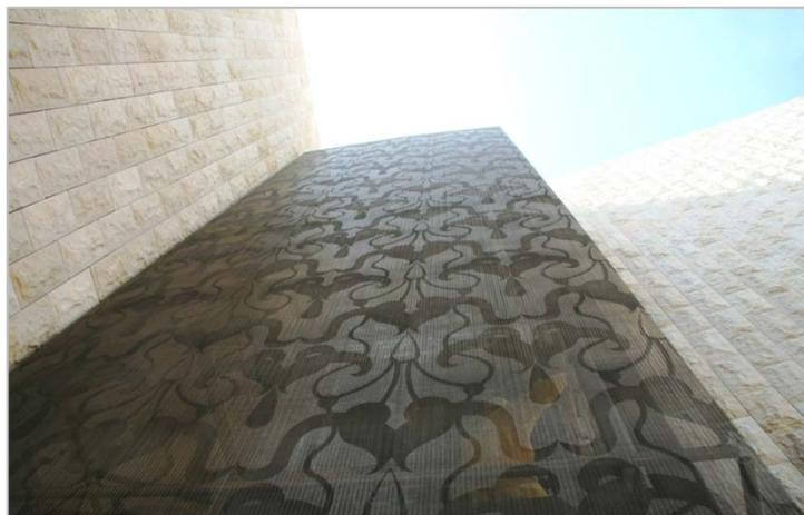
Bild 1: Edeltahlgewebe vom Typ Omega 1520 unterstützt als Sonnenschutz die positive Energiebilanz der neuen Wohnblöcke in Doha.
