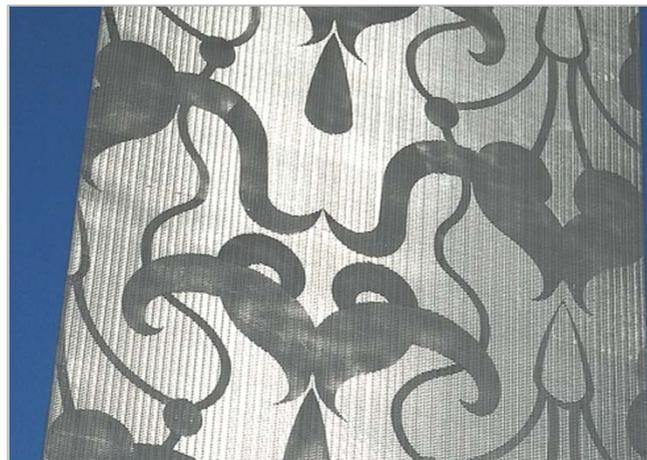
Bild 2: Mit Hilfe eines speziellen Perlstrahlverfahrens wurde das Gewebe mit Ornamenten verziert.
