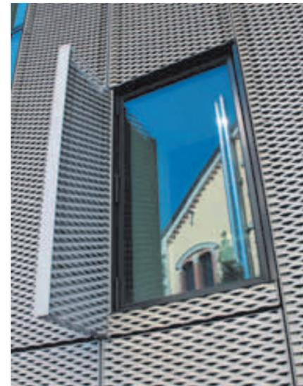
Vertikale Gebäudehülle, horizontale Decke und seitliche "Rippen" als Sonnenschutz an den Fensteröffnungen für einen doppelten Zweck: Verkleidung und Schattierung.
