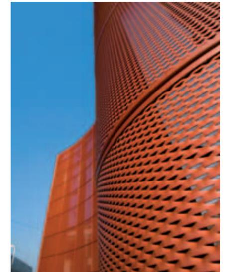
Eine Bühnenkulisse fließend und dynamisch, mit Elementen aus Streckmetall für eine umfassende Sanierung, die den Gebäudecharakter mit der gesamten Fassade in Einklang bringt.
