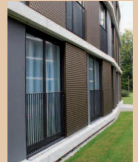
Die verschiebbaren Sonnenschutzelemente können nach Bedarf angeordnet werden und sorgen für einen optimalen thermischen und visuellen Komfort.
