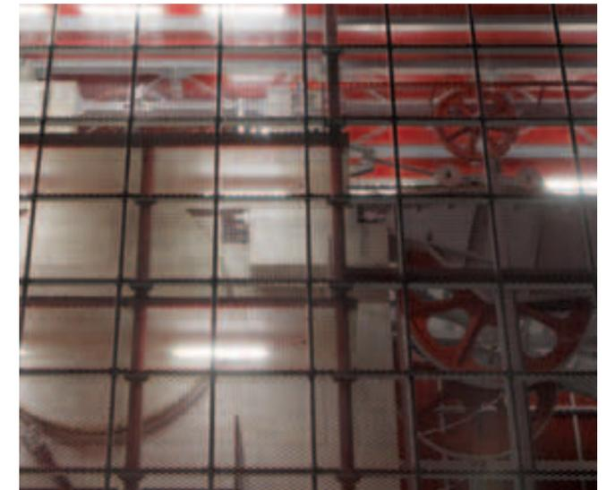
Das Gehäuse der Station und die technischen Räume sind von einem rot lackierten Streckmetall umgeben, das gleichzeitig die Belüftung zu der Räumlichkeiten, ausreichende Beleuchtung und Wetterschutz sicherstellt.
